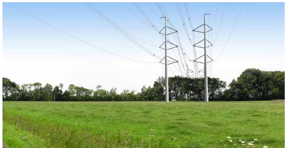
De combinatiemast met een 150 kV- en 380 kV-verbinding.
