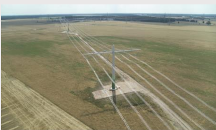
compactLine-Topmasten auf der Platzbreite bei neuen in Sachsen-Anhalt. Foto: Vio & Vio
